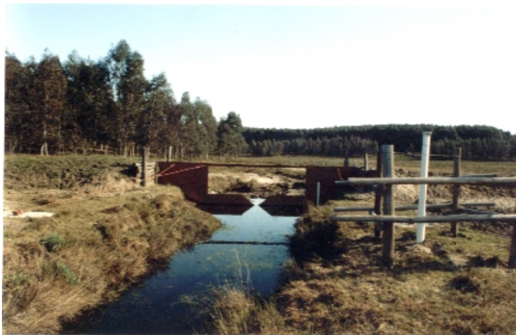
Figura 1. Vista, desde aguas arriba, del cierre ubicado en la microcuenca en monte forestal, constituido por un terraplén provisto con vertedero de lámina delgada, de tipo triangular-rectangular, en su zona central
